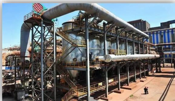
2022年7月份，包钢股份炼钢厂3号转炉一次烟气除尘超低排放示范项目成功热试。
